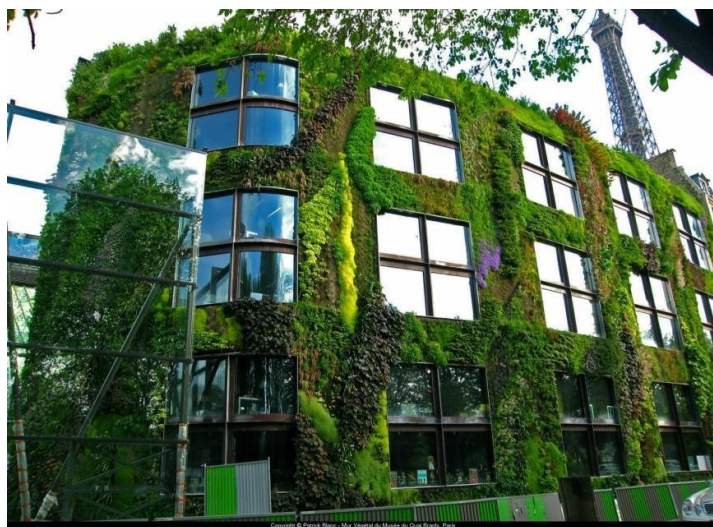
Рис. 1. Зеленый фасад офисного здания
