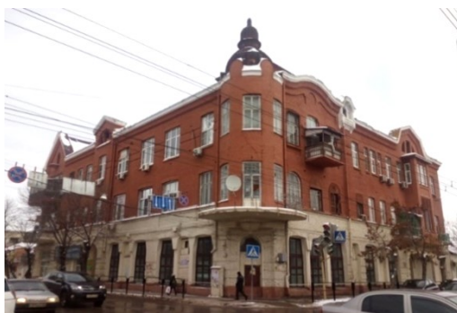
Рис. 1. Современное фото. Общий вид на здание с юго-запада
