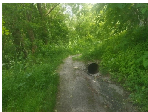
Рис. 3. Сброс сточных вод на территорию оврага «Нижний судок» (фото М. В. Булановой)
