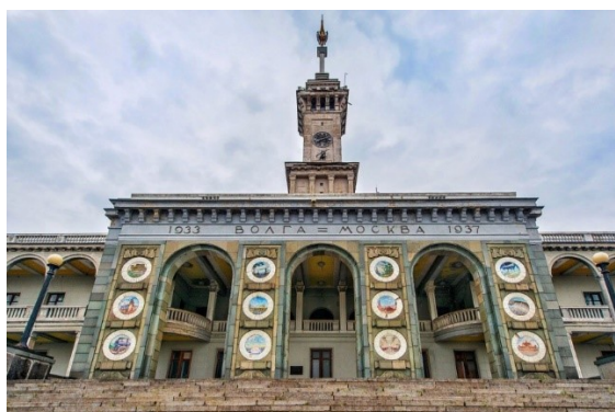
Рис. 4. Северный речной вокзал. Центральная часть
